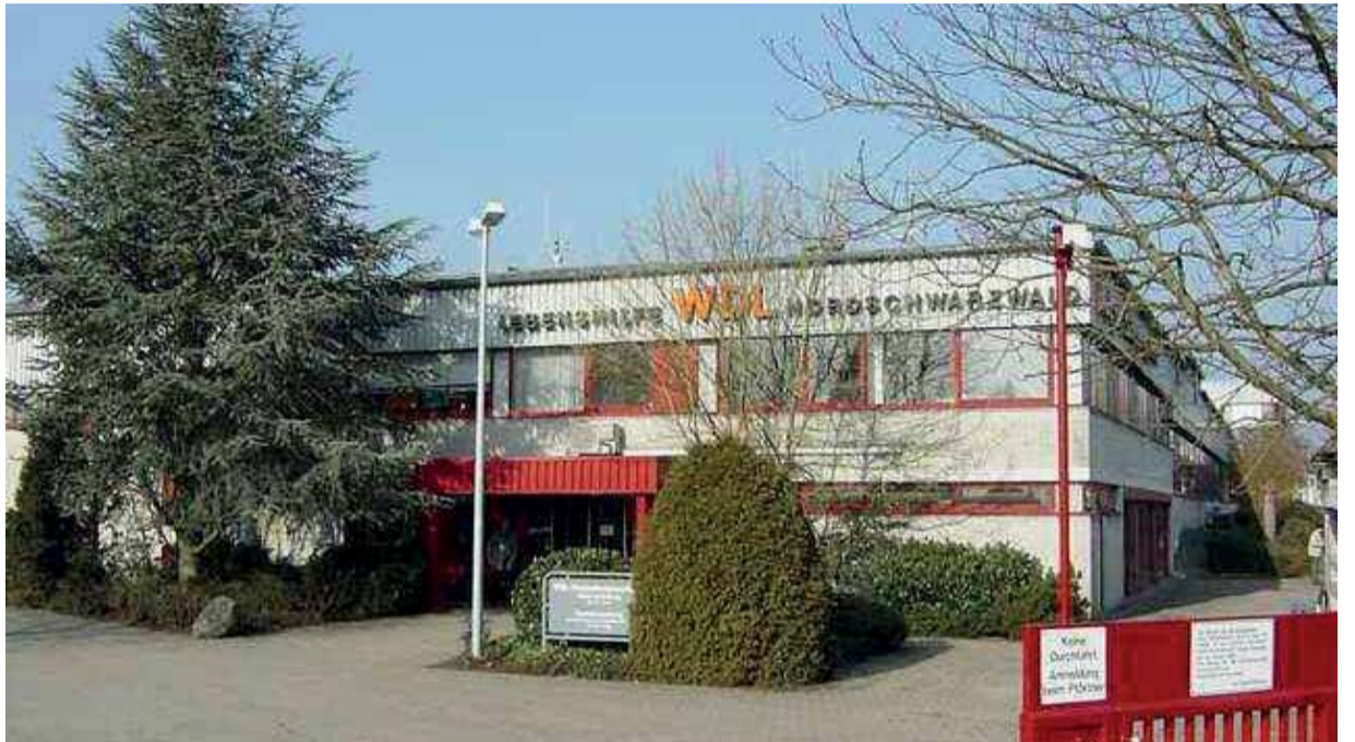
Viele Gebäude unserer Lebenshilfe, wie hier unsere Werkstatt Sinzheim, sind inzwischen in die Jahre gekommen.
