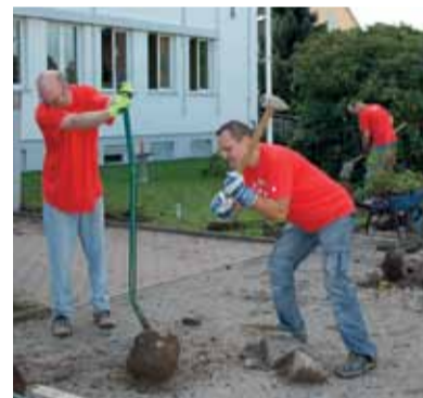
Installation der neuen Zaun- und Toranlage
