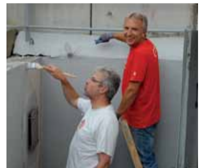
Neuer Anstrich für Sockel und Geländer
