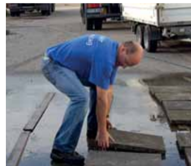
Alte Terrassenplatten wurden abgedampft.
