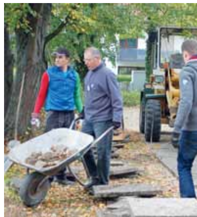
Der alte Belag musste entfernt werden.
