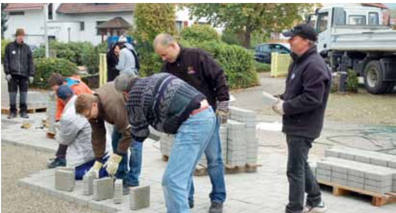
Neues Öko-Pflaster wurde vor der Villa Gelb verlegt.
