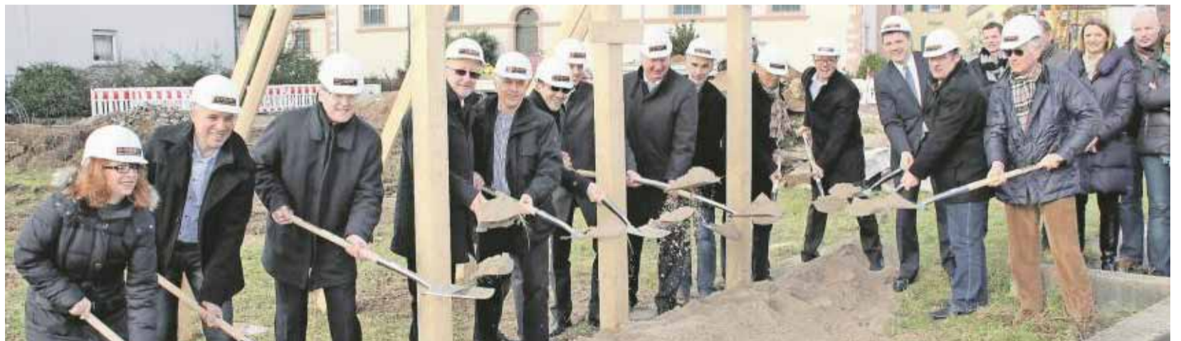
Viel Sand fliegt durch die Luft beim Startschuss für das Großprojekt in der Sandweierer Ortsmitte
