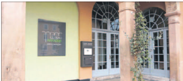
Das Illenau-Museum ist fertiggestellt.
